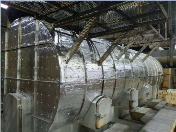
＜ロータリーキルン施工後＞
